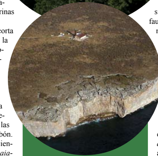
Aspecto de los acantilados del norte de la isla de Mona que se elevan 80 metros sobre el mar. La vegetación en esta área está constituida por un matorral bajo. También se pueden apreciar las instalaciones del faro diseñado por Alejandro Gustavo Eiffel.
