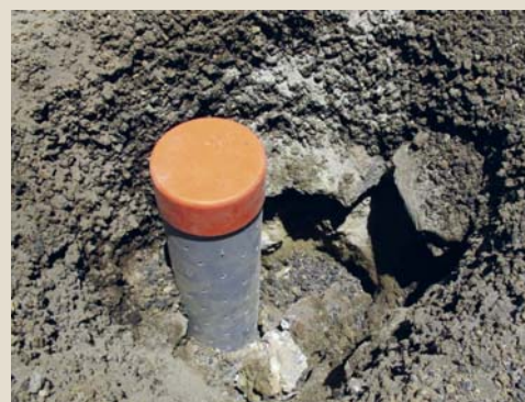
Detalle de la superficie perforada del tubo y su tapa.
